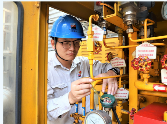
浙能温电迎峰度夏期间在高温下校验压力开关
