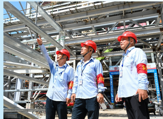
浙能台二电全力推进二期工程建设战迎峰度夏
