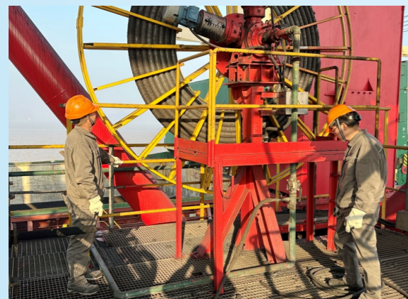
浙能北电开展迎峰度冬检查工作
