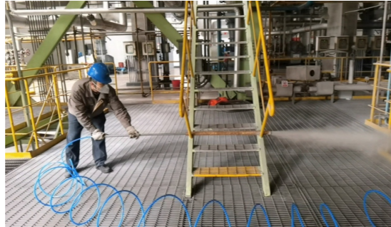
仪控人员正在进行吹扫装置试验
