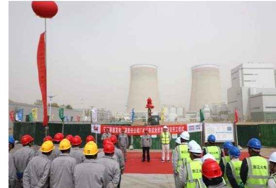
枣泉发电场内分布式光伏发电项目开工
