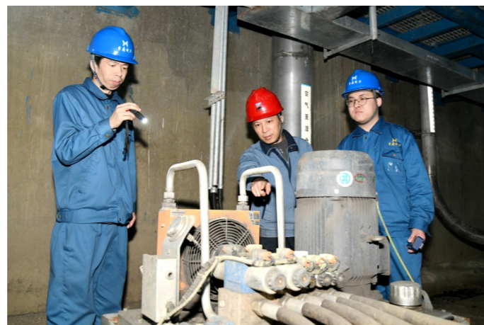
台州电厂 单月污泥处置破7000吨创新高
