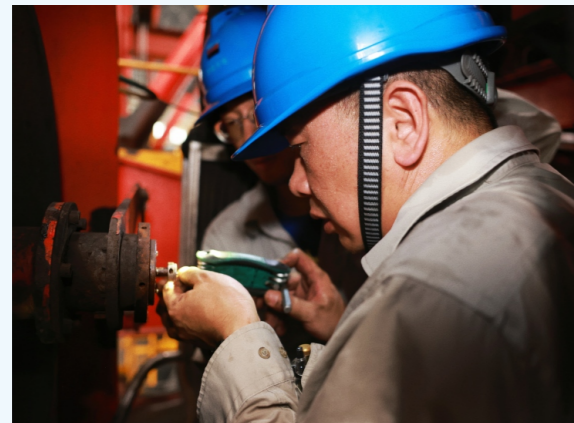
浙能乐电对斗轮机俯仰编码器进行检修
