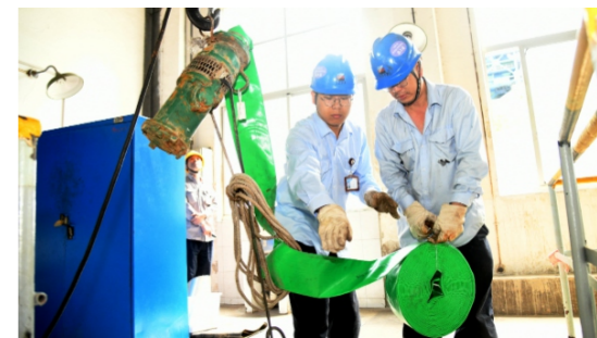
台州电厂操作排涝设施
