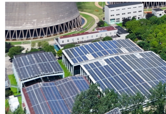
浙能长电光伏发电光棚
