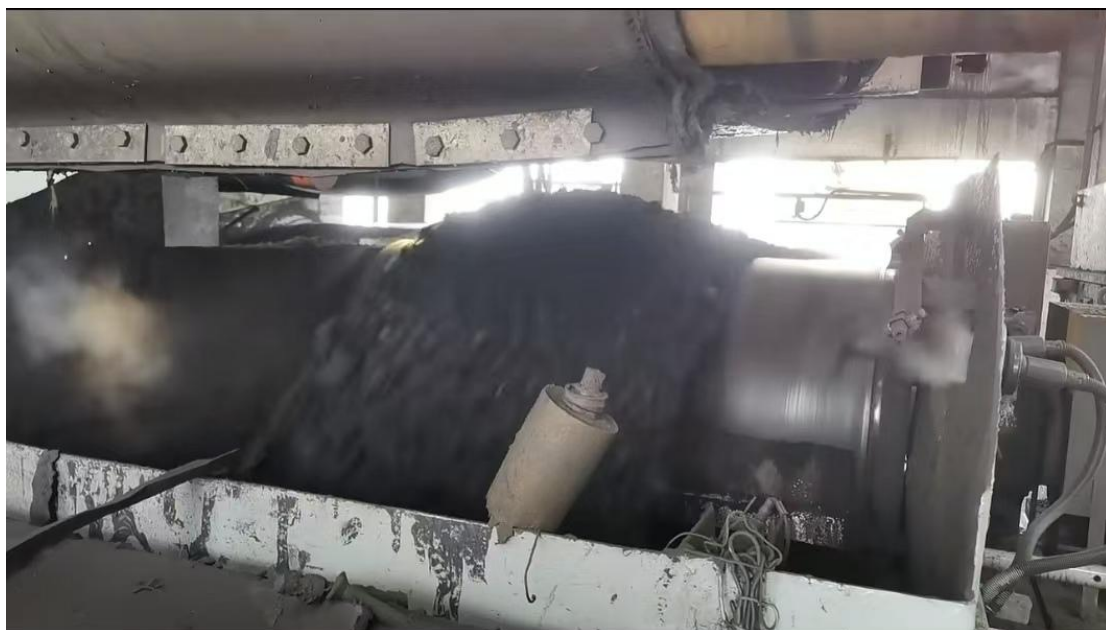
码头皮带机挡风墙
